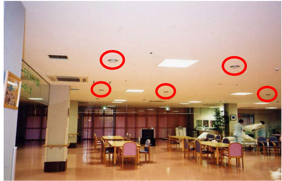
ホール 空気が常に対流しているのが気持ち良い
